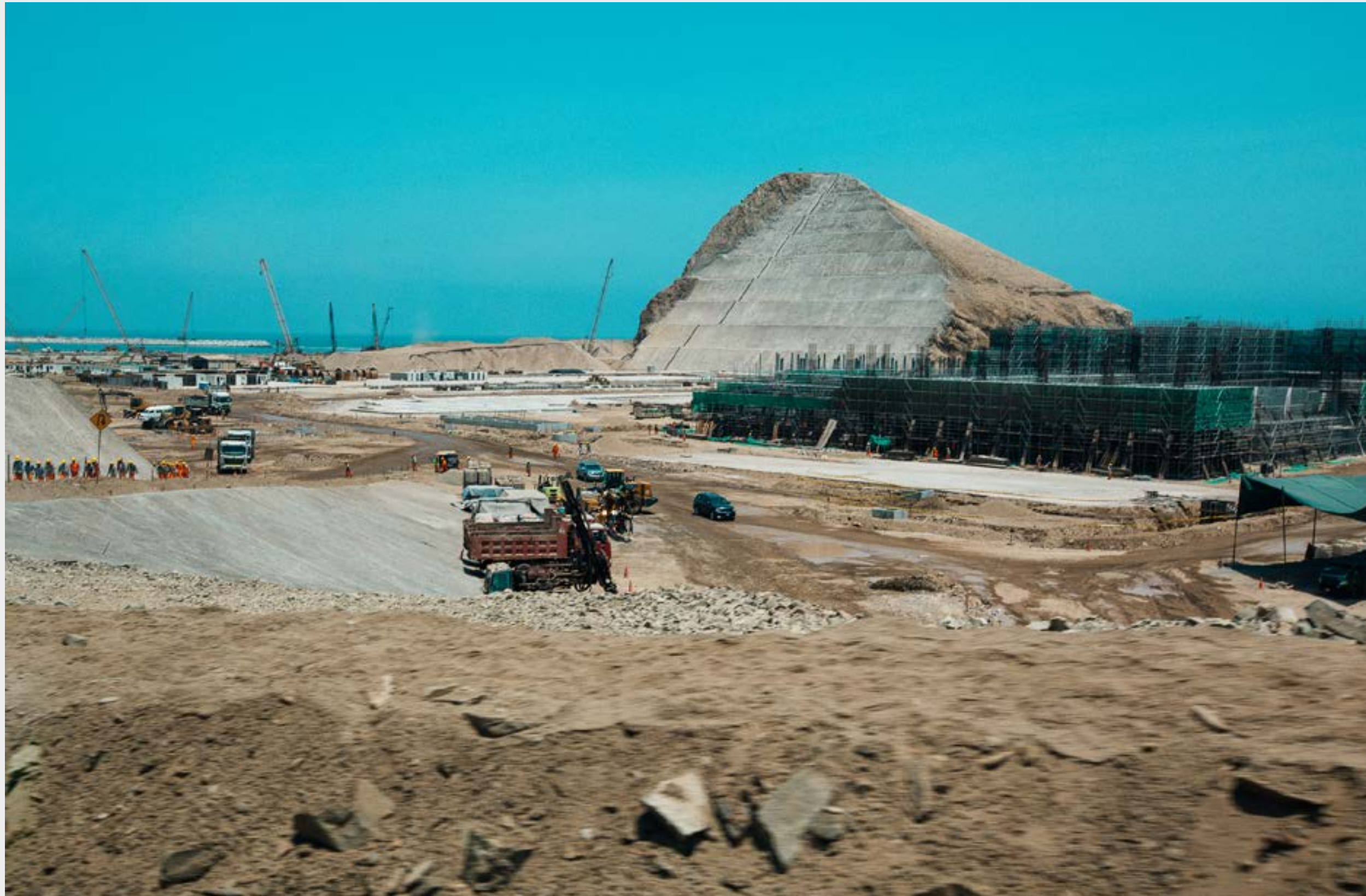
PORTO DE CHANCAY, NO PERU
